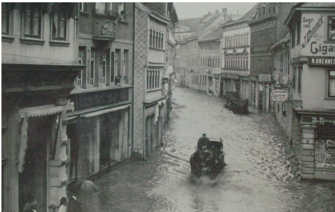
Abb. 5.4-2: Überflutete Töpferstraße in Nordhausen am 17. Mai 1910. (Quelle: Bilderchronik Stadtarchiv Nordhausen)
